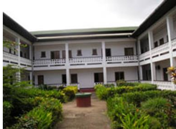
Figura 6 Interior del patio del centro de Salud donde viven las hermanas.
